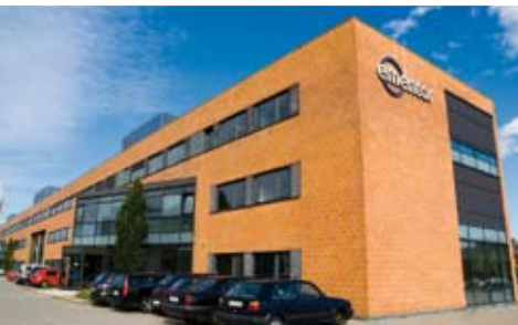
Fastigheter i Köpenhamn.
