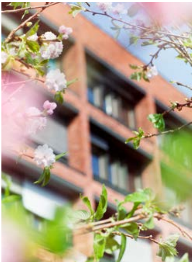
I fastigheten Uven 9 har vi under 2017 genomfört energibesparingsinitiativ samt påbörjat en certifiering till Miljöbyggnad Brons i samband med en renovering. Genom insatser i fastighetstekniken har vi sänkt värmebehovet med ca 25 procent och förbrukningen av fastighetsel med ca 40 procent. Detta ger en besparing på 210 000 kWh, vilket innebär en ekonomisk besparing på cirka 200 000 kr per år.
