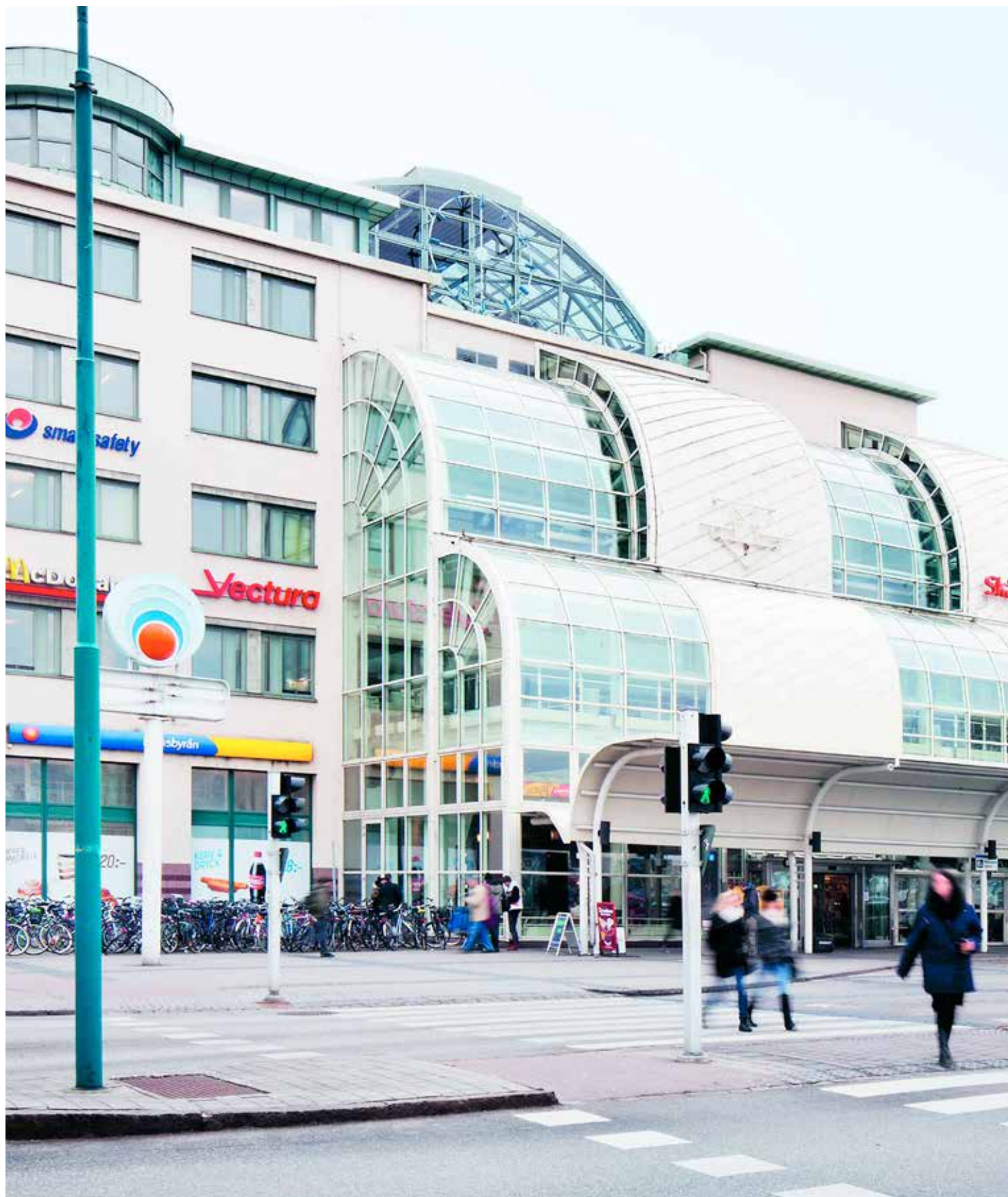
Terminalen 1, Knutpunkten, i centrala Helsingborg. Här skapas 8 000 m 2 nya kontorslokaler som är inflyttningsklara våren 2016.
