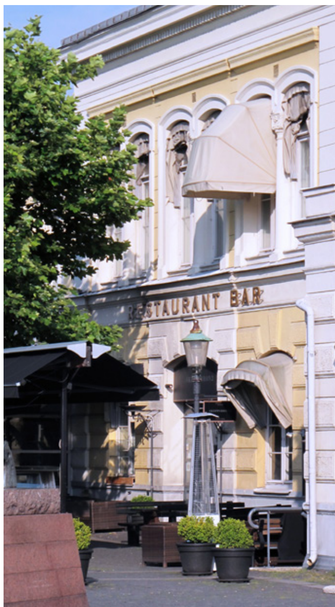
Börshuset i Malmö med sin nyrenoverade fasad.
