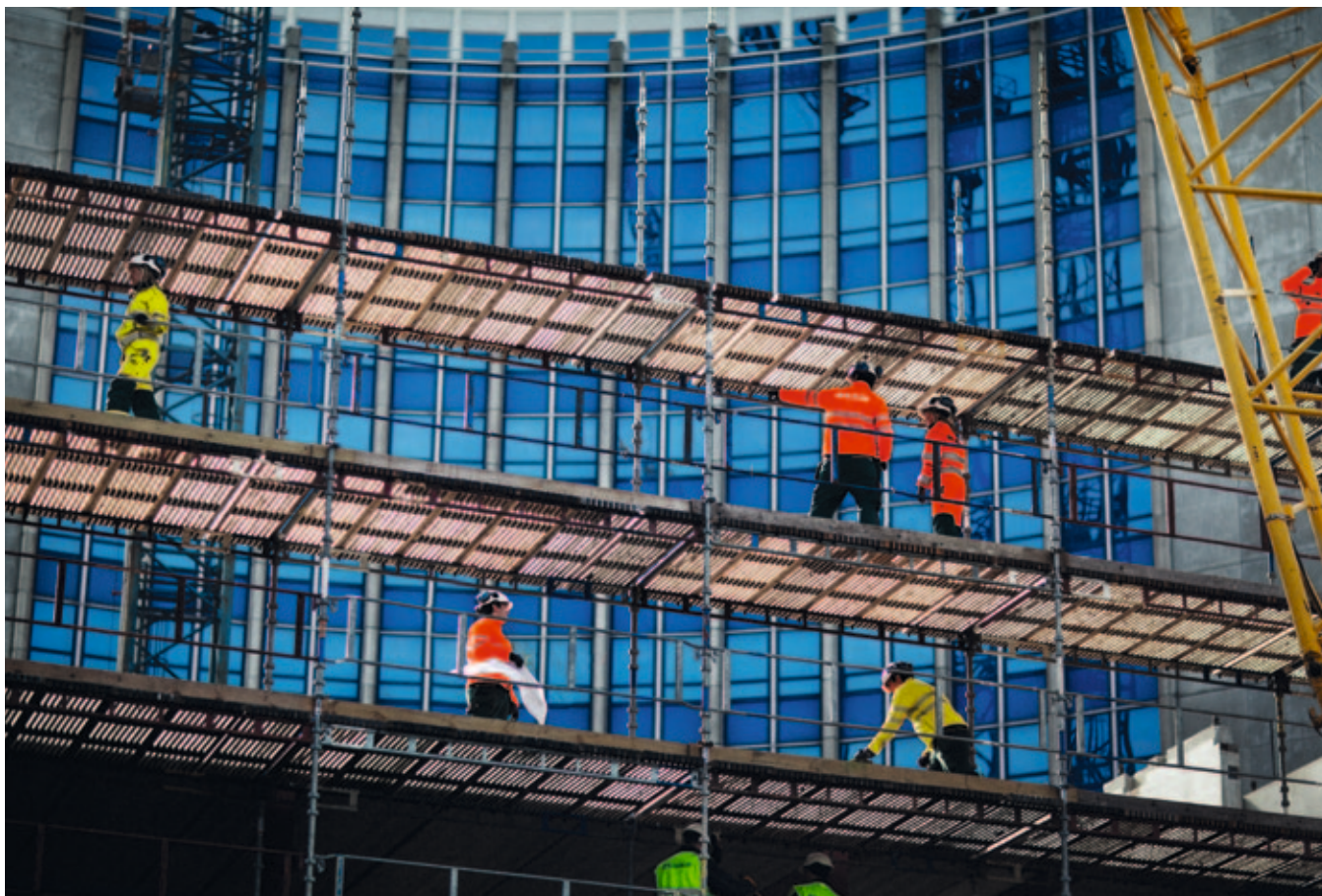
Byggandet av Fören pågår för fullt. Fören kommer att vara GreenBuildingcertifierad och miljöklassad enligt certifieringssystemet "Miljöbyggnad". Klassningen på fastigheten kommer att vara på silvernivå.
