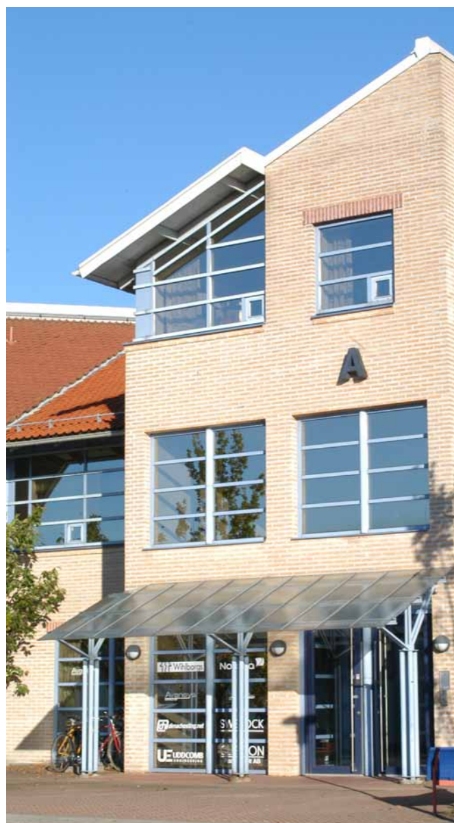
Wihlborgs Helsingborgskontor inryms i fastigheten Floretten 3 på Berga.
