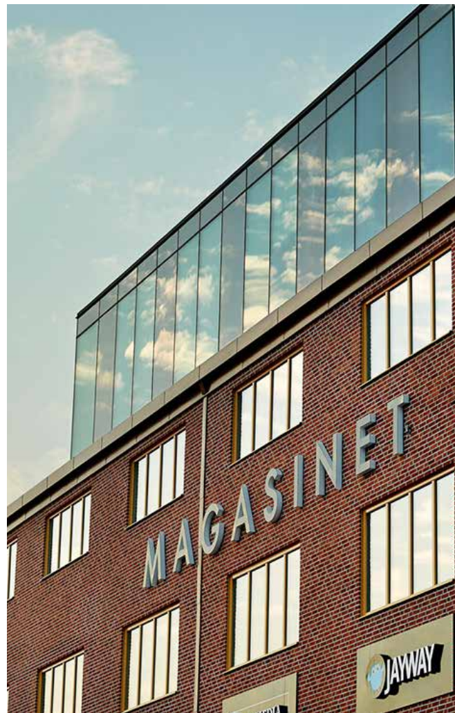
Magasinet som under decennier tog hand om godset från båtarna har totalrenoverats och fått ett nytt liv med våra hyresgäster ArjoHuntleigh AB, LRF Media och Jayway AB.
