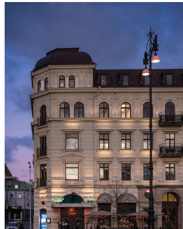
Skiffern 2 i Lund och Svea 7 i Helsingborg är två av Wihlborgs fastigheter som blivit certifierade enligt Miljöbyggnad iDrift.
